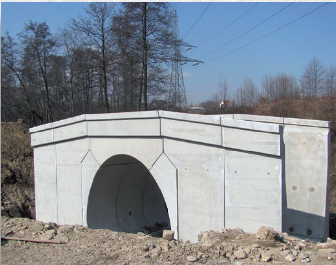
PRZEBUDOWA MOSTÓW W CIĄGU DROGI KRAJOWEJ NR 37
