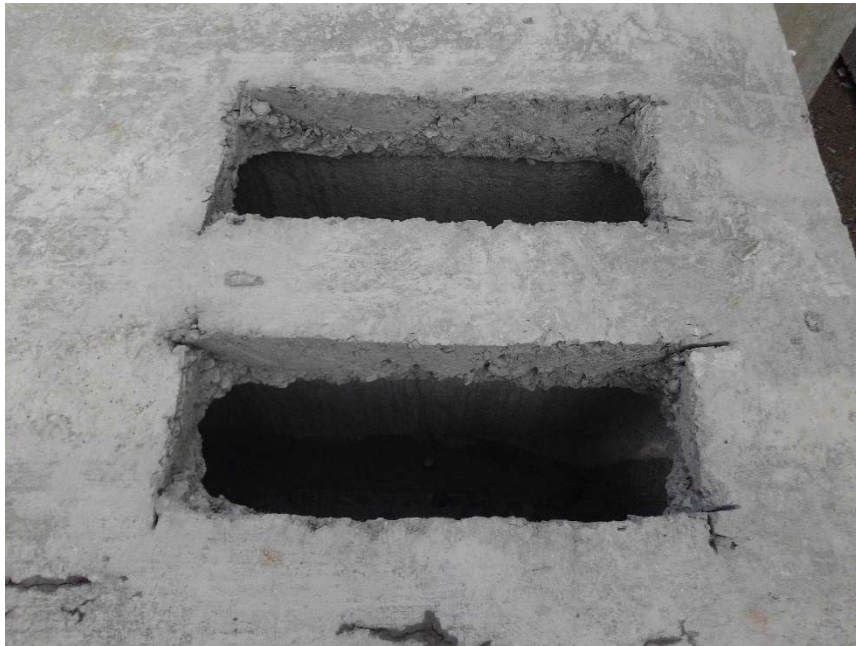
Fot.1.4 Stan otworów wykonanych na mokro
