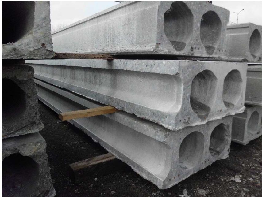
Fot.1.2 Stan krawędzi płyt przy powierzchniach ciętych
