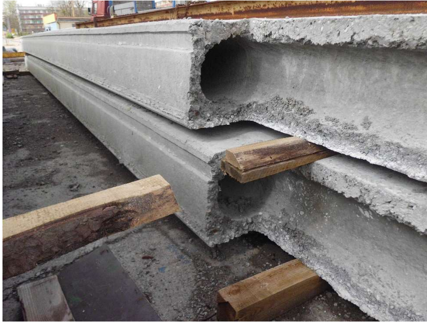
Fot.1.3 Stan krawędzi wycięć wykonanych na mokro
